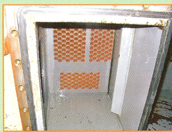
BCS設置5ヵ月後の開放画像(井戸水)
